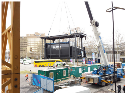
HABA MEGA järjestelmän asennus valmiiseen kaivantoon kestää 3-4 tuntia.
